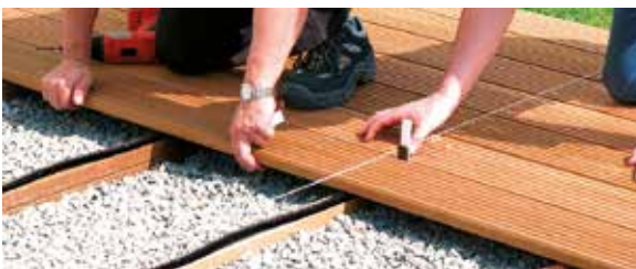
Lehre für gleiche Fugenabstände
