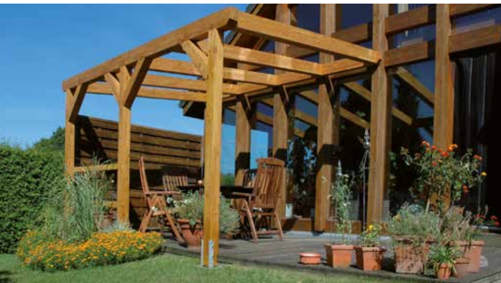
offenes Terrassendach aus Lärche - Leimholz, bauseits lasiert
