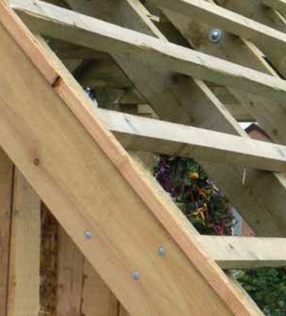
Lärche – Dachstuhl im Detail
