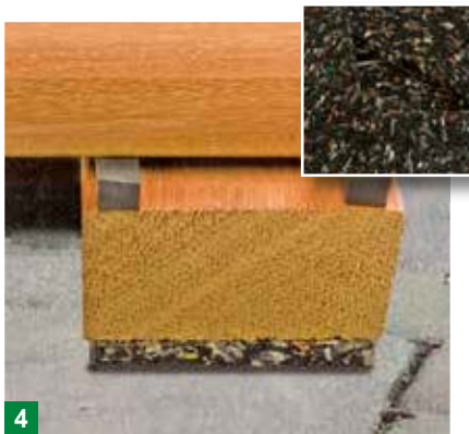
4 Gummi reguliert: Höhenausgleich-Pads für die Unterkonstruktion.
