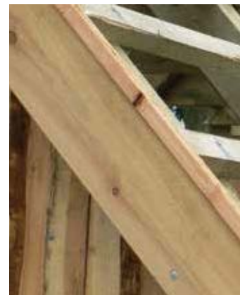
Lärche - Dachstuhl im Detail
