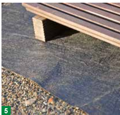
5 Wasserdurchlässiges Abdeckvlies gegen Durchwurzelung u. Pfützenbildung.
