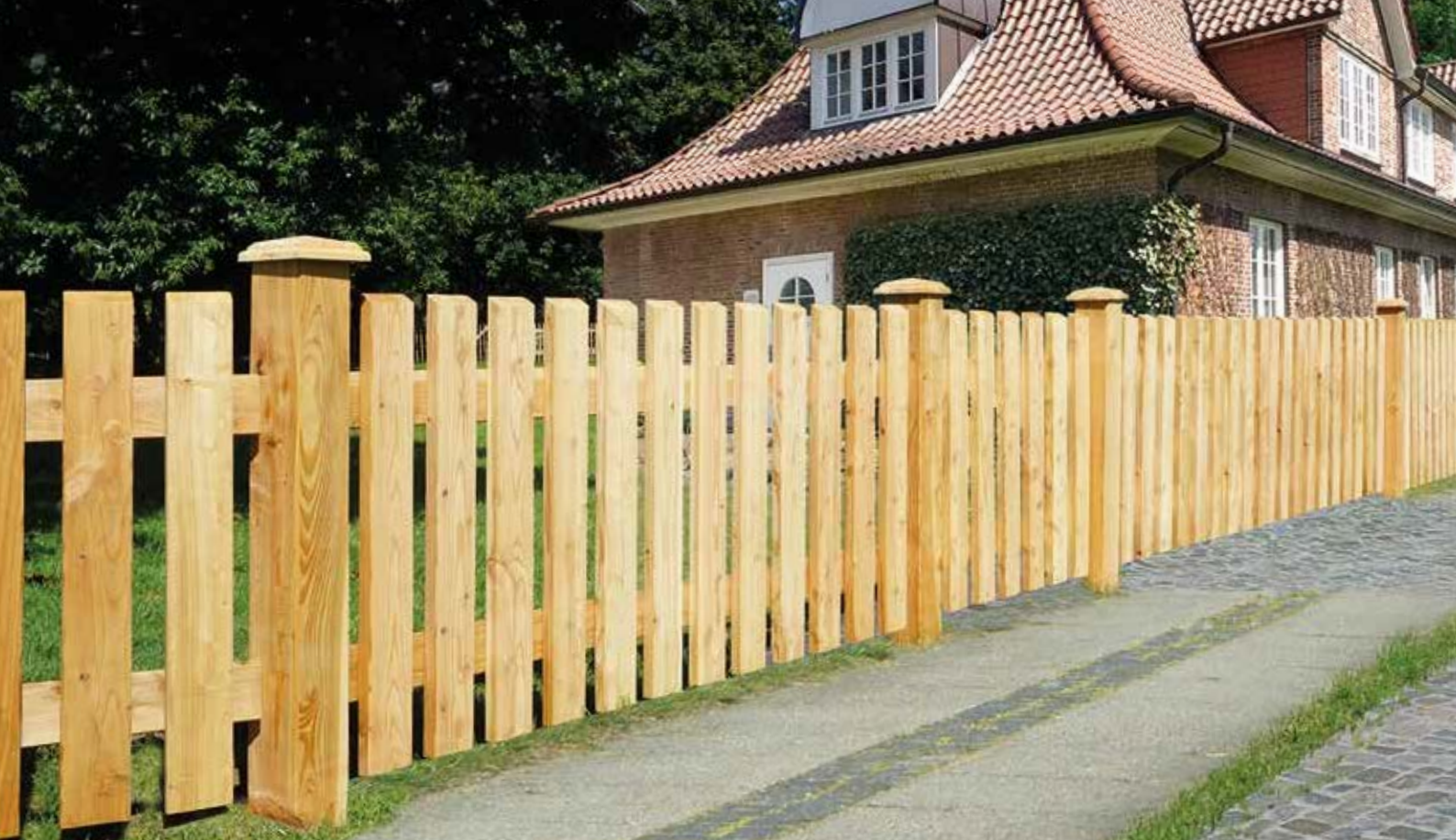
Fördezaun mit Pforte
