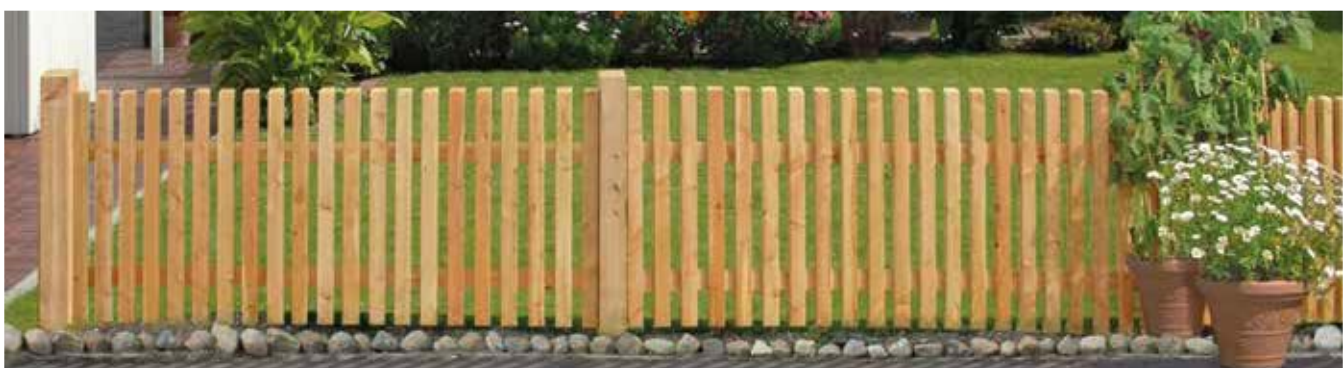
Lattenzaun aus Lärche
