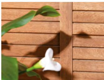
An der Unterseite leicht angeschrägen Lamellen erlauben – je nach Blickwinkel – eine leichte Einsicht
