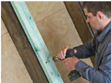
4. Die Sparren auf Tragfähigkeit prüfen und aufdoppeln. Dadurch werden die verlängerten Dachüberstände zusätzlich ausgesteift und die geforderten Dämmdicken gemäß der aktuell gültigen EnEV eingehalten.
