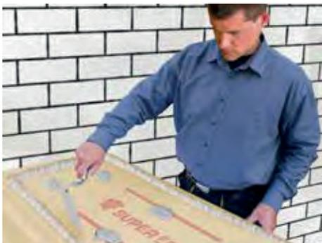
A. Auf das SUPERFOAM 280 GKP XPS den Klebmörtel (z. B. weber.therm 370) im Punkt-Wulst-Verfahren mit einer Kelle auftragen. Die seitlichen Kanten bleiben dabei kleberfrei. Der Untergrund muss tragfähig und trocken sein.
