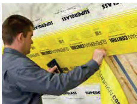
5. SUPERBRAN TRIO / -CONTROL-Dampfbremse mit 10 cm Überlappung von oben nach unten gerade und spannungsfrei quer zum Sparren verlegen und mit einem Handtacker fixieren. Die beschriftete Folienseite zeigt zum Verarbeiter.
