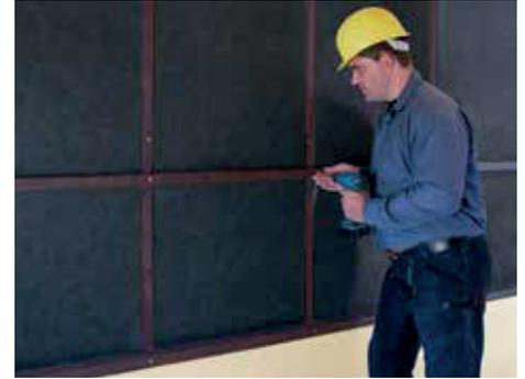
3. Das waagerechte Unterkonstruktionsholz (2. Lage) anschrauben (Abstand: Dämmstoffbreite – 5 mm). Es ist zwar nicht mehr zwingend erforderlich, aber durchaus von Vorteil, imprägniertes Holz zu verwenden.
