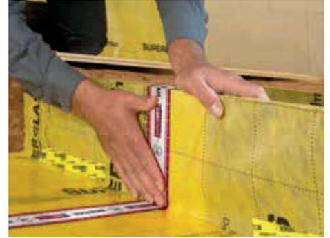
3. Folienüberlappungen und Stöße der Dampfbremsefolie SUPERBRAN TRIO mit dem SUPERFORTE-Klebeband spannungsfrei und luftdicht untereinander verkleben. Staubablagerungen vorher mit einem Tuch abwischen.
