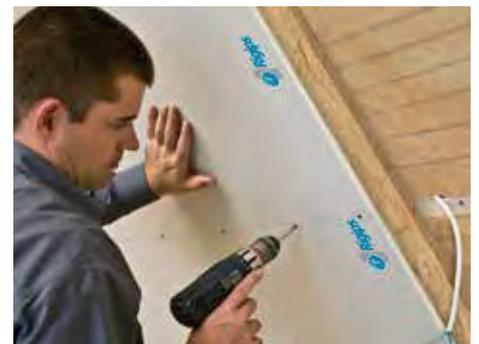
12. Abschließend die Innenverkleidung aus OSB- und Gipskartonplatten auf die Installationsebene montieren. Dabei ist darauf zu achten, dass die Platten mit versetzten Stößen angeordnet und Kreuzfugen vermieden werden.
