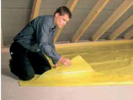
1. SUPERBRAN TRIO- / CONTROL-Dampfbremse mit Übermaß für Folienüberlappungen vollflächig auslegen und zum Anschluss an die umliegenden Bauteile wie Fußpfetten und Giebelwände entsprechend seitlich mindestens 10 cm hochklappen.
