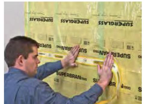
6. Die Folienüberlappungen der Dampfbremssfolie mit den Klebebändern SUPERCRAL oder SUPERFORTE spannungsfrei und luftdicht verkleben. Staubablagerungen vorher mit einem Tuch abwischen.
