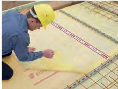
2. Um ein Eindringen des Ortbetons in die Plattenfugen zu verhindern, als Trennlage zwischen Dämmung und Bodenplatte die SUPERFOL-Dampfbremssolie auslegen und die Überlappungen falls erforderlich mit dem SUPERFORTE-Klebeband verkleben.
