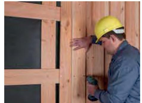
6. Nach der Montage der waagerechten Traglatten wird die Außenverschalung (z. B. eine Boden-Deckel-Schalung) montiert. Für die Konterlatten und Traglatten sollte das gleiche Holz verwendet werden wie für die abschließende Verschalung.
