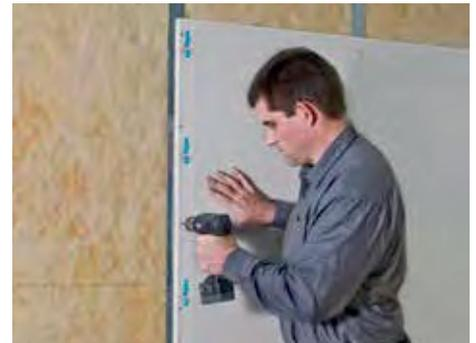
6. Abschließend die vorderseitige Beplankung aus OSB-/Gipskartonplatten montieren. Auch hier sollte man darauf achten, dass die Platten mit versetzten Stößen angeordnet und Kreuzfugen vermieden werden.
