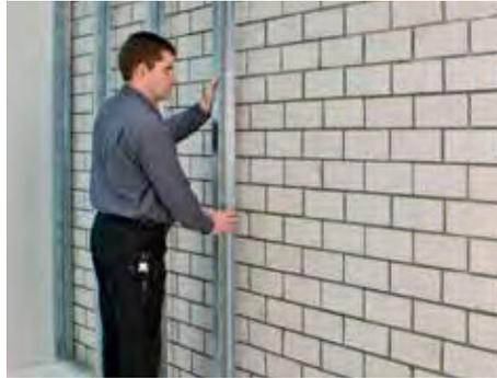
2. Die CW-Metallprofile mit max. 124,5er Achsmaß in die auf dem Boden und an der Decke angebrachten UW-Metallprofile einstellen, lotrecht ausrichten und mit SUPERFORTE oder einer Nietzange in ihrer Position fixieren.
