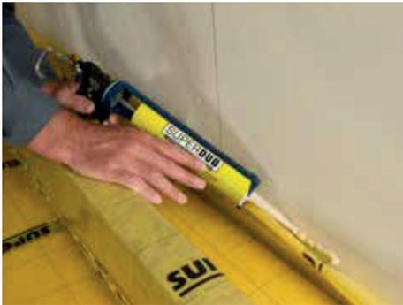
4. Mit dem SUPERDUO-DICHTKLEBER eine 8 mm dicke Kleberaupe auf die umliegenden Bauteile auftragen und die Dampfbremsefolie spannungsfrei andrücken.
