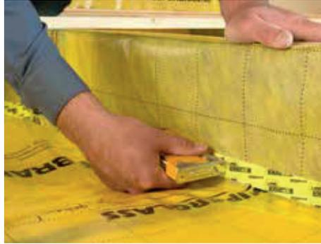
2. Kehlbalken auf Tragfähigkeit prüfen. SUPERBRAN TRIO Dampfbremse schlaufenförmig um die Kehlbalken herum verlegen, quer in die Gefache locker einpassen und mit einem Nageldichtband an der unteren Sparrenwanne fixieren.
