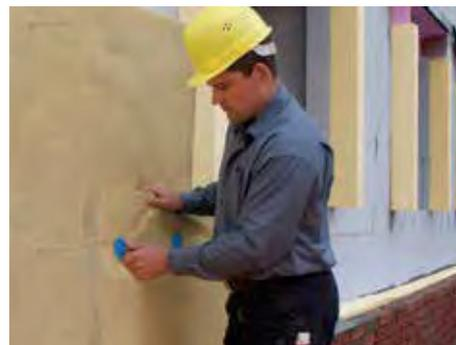
6. Abschließend die Klemmkralle auf die Luftschichtanker aufstecken und die Dämmung in ihrer Position fixieren. Die Luftschichtanker anschließend gemäß Zulassung mit Gefälle nach außen in die Vormauerschale einmauern.
