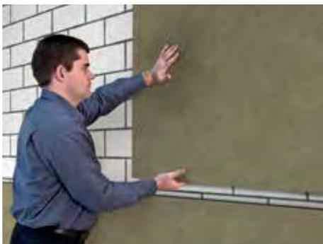
1. Die AKUSTIK HWP 2 in den Wandzwischenraum einstellen und an der ersten Mauerwerksschale vorübergehend fixieren. Dabei sind Kreuzfugen zu vermeiden. Nur für Mauerwerk aus Dickbett- oder Dünnbettmörtel geeignet!
