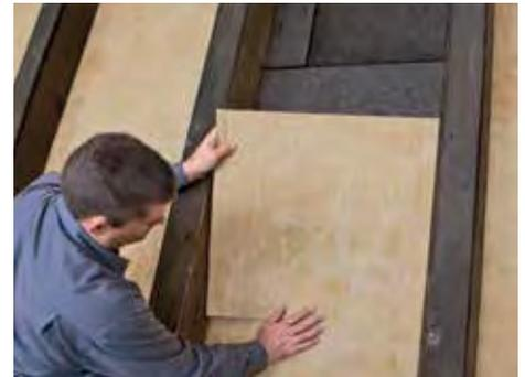
3. Zum Schutz der SUPERBRAN TRIO-Dampfbremssolie vor Beschädigungen durch Nägel/Schrauben die SUPERGLASS TRITTSCHALLDÄMMPLATTEN TS – 032 mit 5 mm Übermaß fugendicht in die Gefache einpassen.
