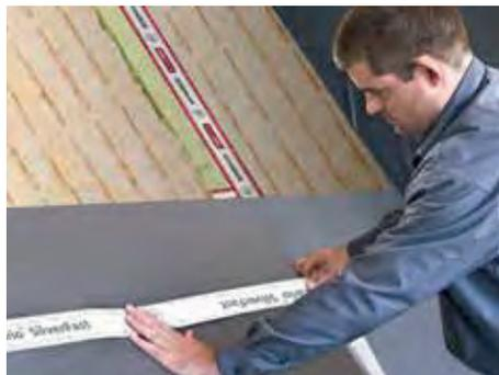
11. Als festes Unterdach und zur Erhöhung des sommerlichen „Hitzeschutzes“ können die SUPERBOARD Holzweichfaserplatten aufgebracht werden. Eine Unterdeckbahn schützt zusätzlich vor Schlagregen.
