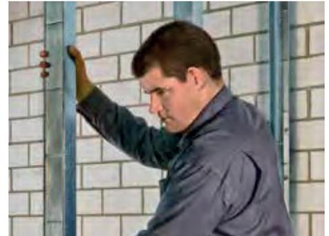
3. Die CW-Profile im Rastermaß von 62,5 cm (bei OSB bis zu 124,5 cm Achsmaß) in die auf dem Boden und an der Decke angebrachten UW-Profile einstellen, lotrecht ausrichten und mit SUPERFORTE oder einer Nietzange fixieren.
