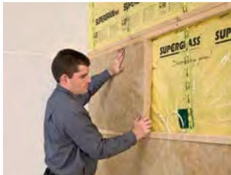
11. Den verbleibenden Hohlraum in der Installationsebene mit einer zusätzlichen Querdämmung ausfüllen. Dazu die SUPERGLASS KERNDÄMMPLATTEN KD 4/V - 032 in 62,5er Breite dicht gestoßen in die Konstruktion einpassen.
