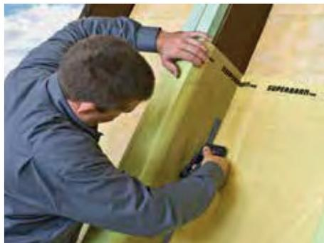
5. SUPERBRAN TRIO schlaufenförmig um die Sparren verlegen, quer in die Gefache locker einpassen, mit einem Nageldichtband an der unteren Sparrenwanne fixieren. Die beschriftete Seite zeigt zum Verarbeiter.
