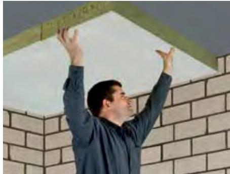
2. Die Platten fugendicht und mit versetzten Stößen an Decke und Wand ansetzen und bei Bedarf mit einem Reibebrett andrücken. Bei unebenen Untergründen kann die Montage mit entsprechenden Tellerdübeln erfolgen.
