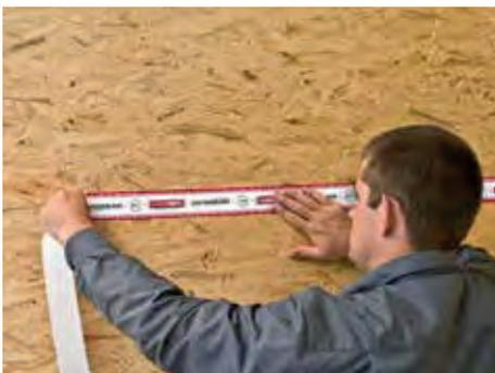
10. Fugen und Stöße von OSB-Platten können mit dem SUPERFORTE-Klebeband luftdicht abgeklebt werden. Das SUPERFORTE/-DUO-Klebeband ist auch für alle Folienverklebungen und Anschlüsse an Durchdringungen geeignet.
