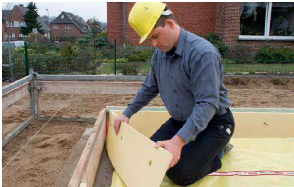
Wärmebrückendämmung an der Stirnseite der Betonbodenplatte
