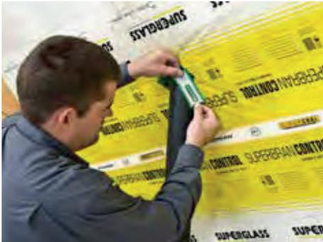
7. Anschlüsse der SUPERBRAN TRIO-Dampfbremssfolie an Durchdringungen und beweglichen Bauteilen mit den Klebebändern SUPERSAN oder SUPERFORTE /-DUO luftdicht herstellen. Auch mit Fertigmanschetten möglich.
