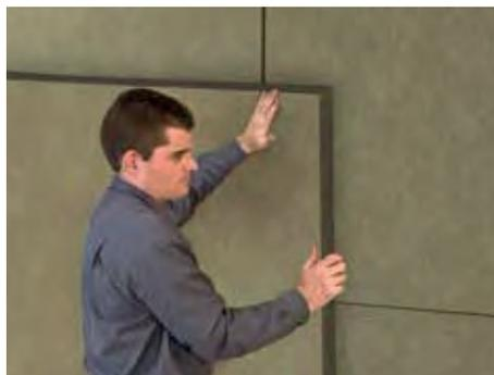
2. Bei Bedarf können die Haustrennwandplatten mehrlagig eingestellt werden. Die zweite Mauerwerksschale wird parallel zum Einstellen des Dämmstoffes Stück für Stück aufgemauert, Kontaktpunkte zwischen den beiden Schalen sind zu vermeiden!
