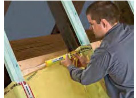
9. Zum Anschluss an die modernisierte Holzbalkendecke von innen an die Sparren ein Stirnbrett anbringen und daran die SUPERBRAN TRIO-Dampfbremsfolie mit dem SUPERDUO-DICHTKLEBER spannungsfrei anschließen.
