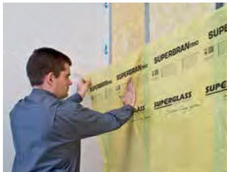
5. Die SUPERBRAN TRIO-Dampfbremssfolie mit 10 cm Überlappung spannungsfrei und quer zu den Profilen verlegen und mit Klebeband am CW-Metallprofil fixieren. Die beschriftete Folienseite zeigt zum Verarbeiter.
