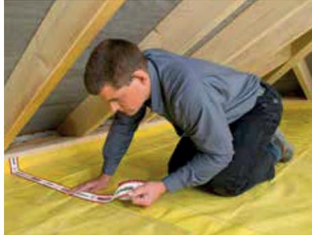
2. Folienüberlappungen (mindestens 10 cm) mit dem SUPERFORTE-Klebeband spannungsfrei und luftdicht verkleben. Staubablagerungen vorher mit einem Tuch abwischen. Für die neue Bodentreppe eine Folienschürze vorsehen.
