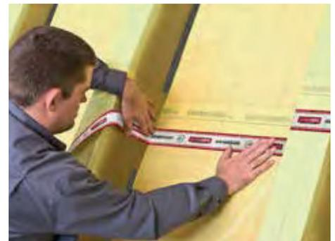
6. Folienüberlappungen und Stöße der Dampfbremssolie SUPERBRAN TRIO mit dem SUPERFORTE-Klebeband spannungsfrei und luftdicht untereinander verkleben. Staubablagerungen vorher mit einem Tuch abwischen.
