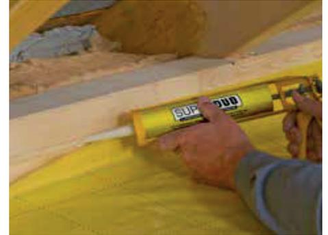
3. Mit dem SUPERDUO-DICHTKLEBER eine 8 mm dicke Kleberaube auf die umliegenden Bauteile wie Fußpfetten und Giebelwände auftragen und die SUPERBRAN TRIO- / CONTROL-Dampfbremse spannungsfrei mit der flachen Hand andrücken.
