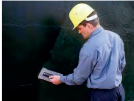
2. Anschließend die Bitumendickbeschichtung oder die bitumenfreie Dickbeschichtung mit einer Glättekele – je nach Feuchtigkeitsbeanspruchung ein- oder mehrmalig – vollflächig auftragen. Durchtrocknungszeiten und geforderte Endschichtdicke beachten.
