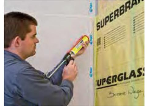
9. Mit dem SUPERDUO-DICHTKLEBER eine 8 mm dicke Kleberaupe auf die umliegenden Bauteile wie Boden, Decke und Wände auftragen und die Dampfbremsfolie spannungsfrei als Schlaufe gefaltet andrücken.
