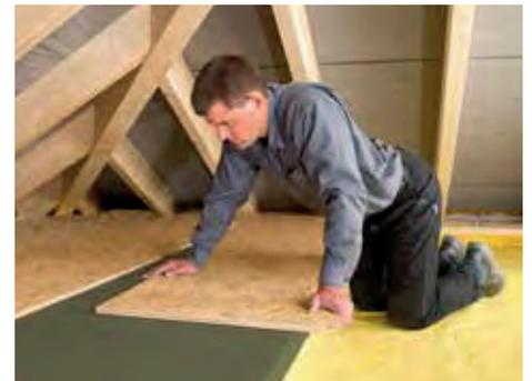
6. Als abschließenden Gehbelag feuchtigkeitsbeständige Spanverlege- oder OSB-Platten (Dicke  $\geq 19$  mm) auf den TOPDEC LOFT Dachbodendämmplatten schwimmend verlegen und an den Plattenfugen und -stößen verleimen.
