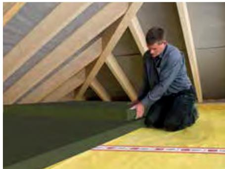
5. Durch eine mehrlagige Verlegung mit versetzten Stößen wird die Dämmwirkung erhöht und Wärmebrücken werden vermieden. Die TOPDEC LOFT Dachbodendämmplatten sind allerdings nicht für Wohnraumzwecke geeignet!
