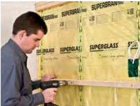
10. Danach eine Installationsebene (Zwischenmaß 62 cm) zum Schutz der Dampfbremsfolie und zur Aufnahme von Kabeln und Rohrleitungen anordnen. Zur schalltechnischen Entkopplung ein Schallentkopplungsband auf das Ständerwerk aufkleben.
