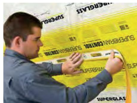
6. Folienüberlappungen der Dampfbremse mit den Klebebändern SUPERCRAL oder SUPERFORTE spannungsfrei und luftdicht verkleben. Staubablagerungen vorher mit einem Tuch abwischen.
