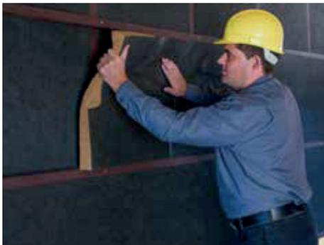
4. Den Dämmstoff fugendicht einpassen. Bei Bedarf mit 2 Tellerdübeln/Platte mechanisch fixieren. Als zusätzlicher Schutz kann eine diffusionsoffene Unterdeckbahn montiert und winddicht mit SUPERFORTE-Klebeband verklebt werden.
