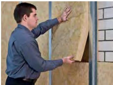
4. In das Ständerwerk die SUPERGLASS KERNDÄMMPLATTEN KD 4/V - 032 mit dem Vlies zur Außenwand einpassen. Die Dämmung sollte insgesamt mindestens 80 mm stark sein, bei Sichtfachwerkswänden höchstens 50 mm.
