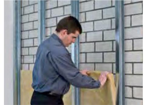
3. Zur Vermeidung von Wärmebrücken die SUPERGLASS TRITTSCHALLDÄMMPLATTEN TS - 032 zwischen dem Ständerwerk und der Außenwand vollflächig einsetzen. Dämmstoffdicken gemäß der aktuell gültigen EnEV dimensionieren.
