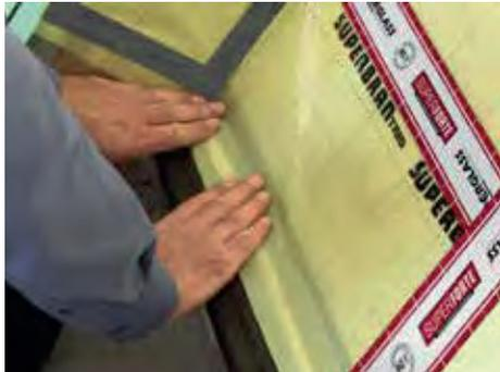
7. Mit dem SUPERDUO-DICHTKLEBER eine 8 mm dicke Kleberaube auf die umliegenden Bauteile wie Giebelkronen und Fußpfetten auftragen und die Dampfbremsfolie spannungsfrei andrücken. Klebeflächen vorher reinigen/abfeigen.
