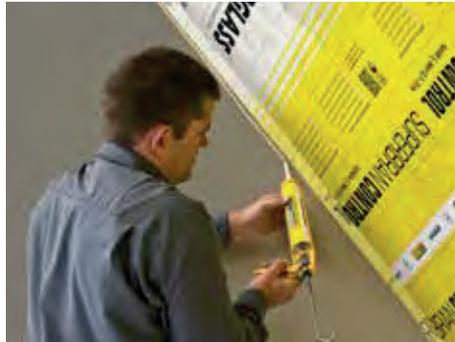
8. Mit dem SUPERDUO-DICHTKLEBER eine 8 mm dicke Kleberaupe auf die umliegenden Bauteile wie Giebelwände und Fußpfetten auftragen und die Dampfbremssfolie spannungsfrei, als Schlaufe gefaltet, andrücken.
