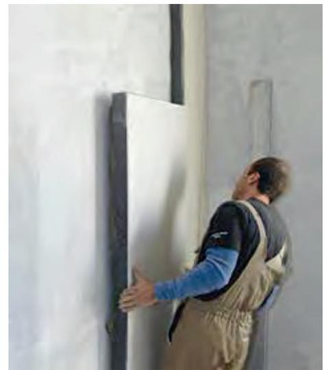
Wand- und Bodendämmung mit EPS
