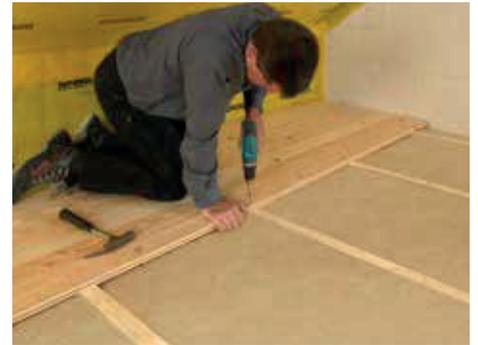
6. Kerndämmplatten KD 4/V – 032 einlegen und darüber diffusionsoffene Holzweichfaserplatten + Konterlattung und Nut- und Federbretter als Bodenbelag verlegen. Keine „dichten“ OSB- oder Spanverlegeplatten verwenden.
