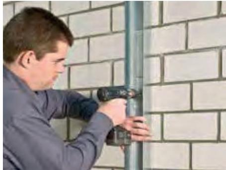
2. Die CW-Profile an den Seitenwände mit z. B. Schlagdübeln fixieren. Auch hier je nach Brand- und Schallschutzanforderungen ein Schallentkopplungsband oder einen Dämmstreifen aus Steinwolle in Wandbreite verwenden.
