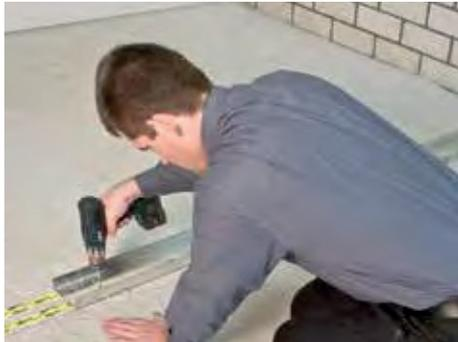
1. Die UW-Metallprofile auf dem Boden und an der Decke fixieren. Zur schalltechnischen Entkopplung von den umliegenden Bauteilen ein Schallentkopplungsband oder einen Steinwollestreifen in Wandbreite verwenden.
