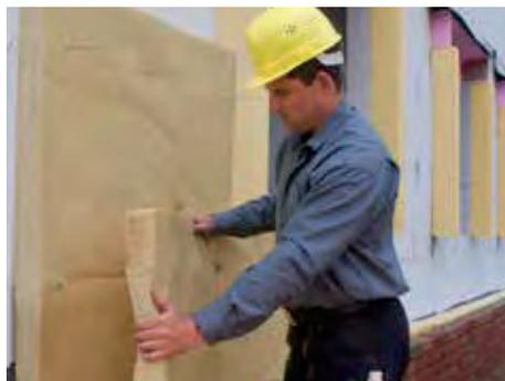
5. Die SUPERGLASS KERNDÄMM-PLATTEN KD 4/V – 032 in entsprechender Dicke gemäß der aktuell gültigen EnEV mit versetzten Stößen auf die Luftschichtanker aufstecken. An den Gebäudeecken sind durchgehende Fugen zu vermeiden.
