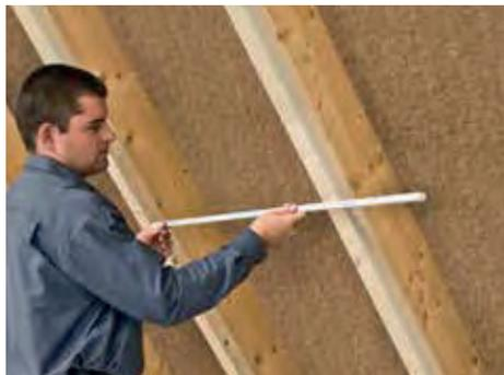
1. Abstand zwischen den Sparren oder Kehlbalken ausmessen und 1 cm Klemmzugabe begeben. Bei Bedarf eine „Aufdoppelung“ der Sparren, z. B. mit hochkant aufgeschraubten 4 × 6er Konstruktionsholz, vornehmen.
