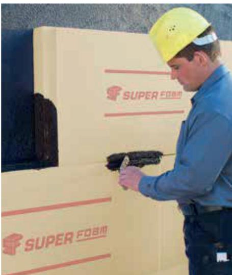
Perimeterdämmung mit XPS + KMB
