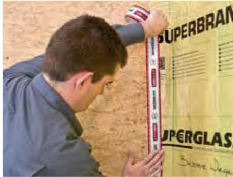
8. Im Holzrahmenbau zum Anschluss der Dampfbrems an OSB-Platten das SUPERFORTE-Klebeband verwenden. Fugen + Stöße von OSB-Platten können mit dem SUPERFORTE DUO Klebeband luftdicht abgeklebt werden.
