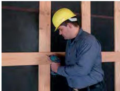
5. Senkrechte Konterlatte (3–6 cm dick, fixiert zus. die Dämmung, Achsmaß ca. 50 cm) montieren, damit evtl. Feuchtigkeit hinter den Traglatten der Außenverschalung abgeführt werden kann. Danach die waagerechte Traglattung befestigen.
