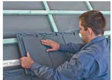
12. Nageldichtband (z. B. ISOVER VARIO ANTISPIKE oder baugleich) auf die Unterdeckbahn im Sparrenbereich aufbringen, Konterlattung und Traglattung entsprechend verlegen und abschließend die neue Dacheindeckung herstellen.
