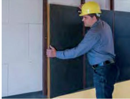
2. Feuchtigkeit oberhalb des XPS mit einer L-Folie nach außen ableiten. Das senkrechte Unterkonstruktionsholz (1. Lage) montieren und die SUPERGLASS FASSADENDÄMMPLATTEN FP 2/V fugendicht einsetzen.
