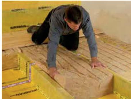
5. SUPERGLASS-KLEMMFILZ KF 4 – 032 in voller Balkenhöhe von oben in die Gefache fugendicht einpassen. Anschließend die zwei 4×6er Konstruktionslatten hochkant aufschrauben, ausrichten und bei Bedarf unterfüttern.
