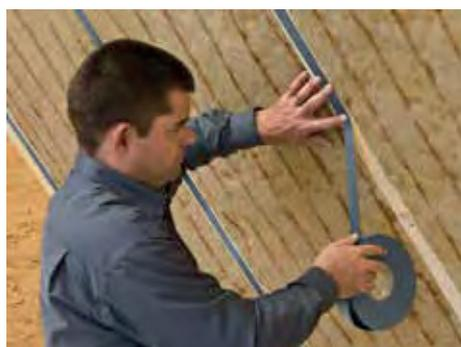
4. Unterkonstruktion mit dunklem Stift auf der „Aufdoppelung“ anzeichnen, Dampfbremse an diesen Stellen antackern, anschließend einen Streifen Nageldichtband (z. B. ISOVER VARIO ANTISPIKE) aufkleben und Querlattung montieren.
