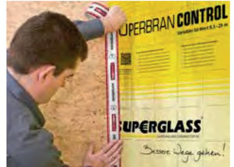
9. Im Holzrahmenbau kann die Dampfbremssfolie spannungsfrei auf z. B. OSB-Platten mit dem SUPERFORTE /-DUO-Klebeband an die umliegenden Bauteile wie Giebelwände und Fußpfetten luftdicht angeschlossen werden.
