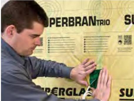
7. Die Anschlüsse der SUPERBRAN TRIO-Dampfbremsfolie an Durchdringungen und beweglichen Bauteilen mit den Klebebändern SUPERSAN oder SUPERFORTE DUO luftdicht herstellen. Auch mit Fertigmanschetten möglich.
