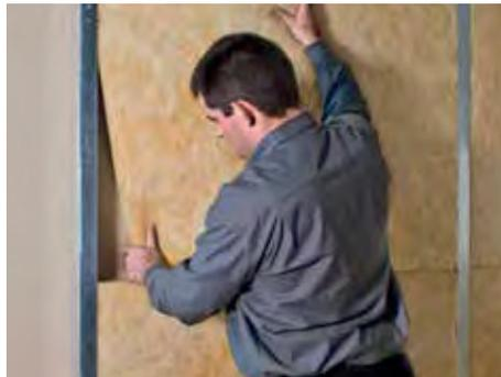
5. Für optimalen Schall- und Brandschutz die SUPERGLASS TRENNWANDPLATTEN TW 1 – 040 dicht gestoßen in das Ständerwerk einstellen. Der Dämmstoff sollte bei hoher Baufeuchte 2 cm dünner als die Profiltiefe sein.
